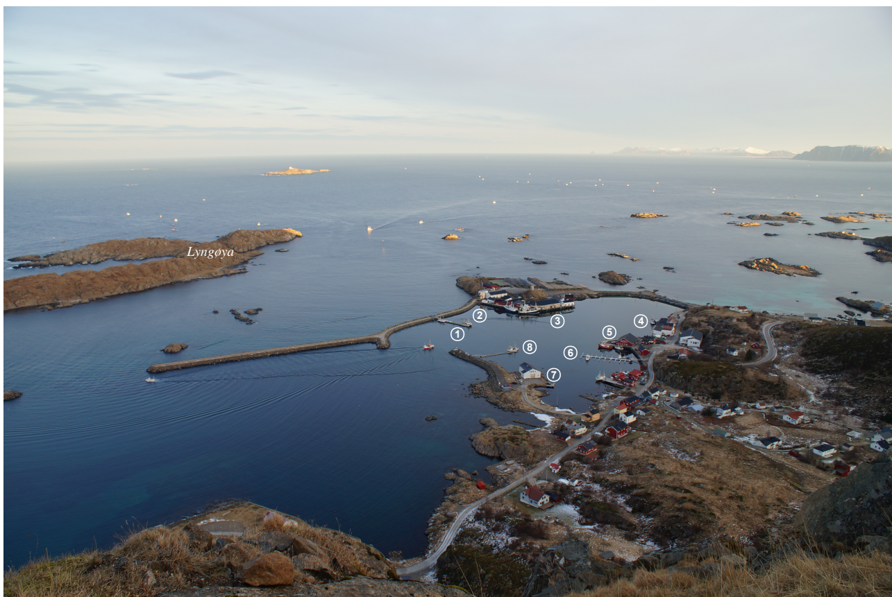
STØ sett fra SSW
